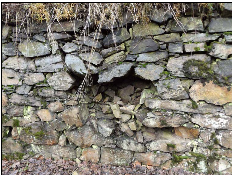
Obr. č. 4 - detailní pohled na porušení zdi
