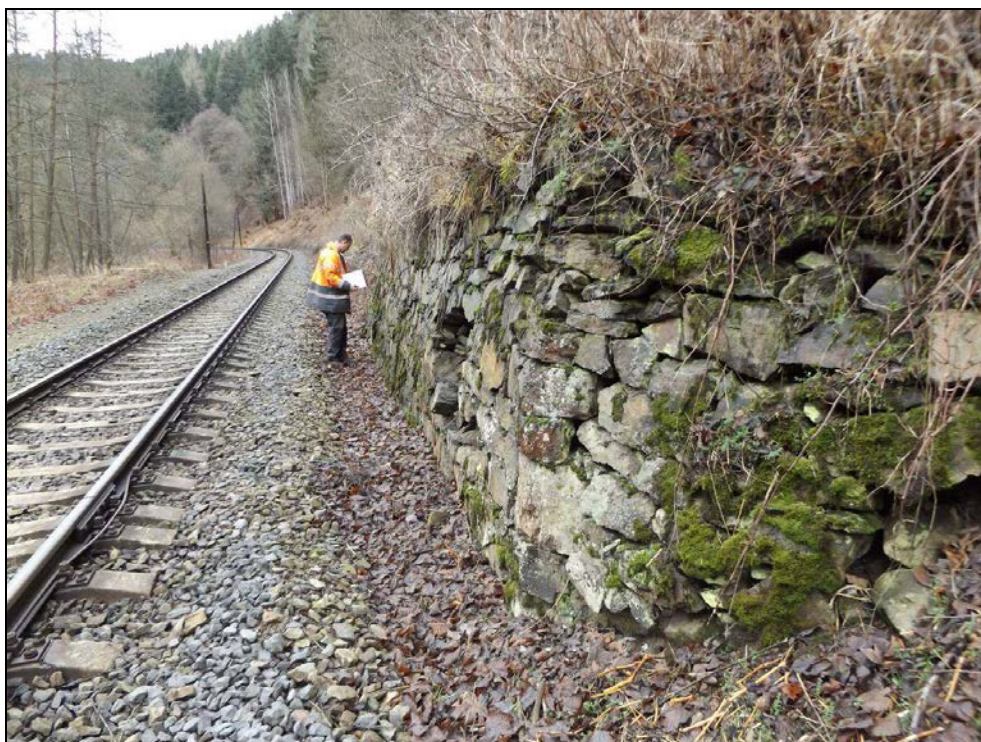
Obr. č. 5 - pohled na ZZ a její porušení od konce směrem k Mariánským Lázním. Zdivo ZZ bylo provedeno na sucho bez použití malty a dnes je většina zdi nestabilní a boulí se.
